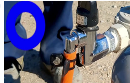
ガス栓へのゴム管の挿入不足がない状態
